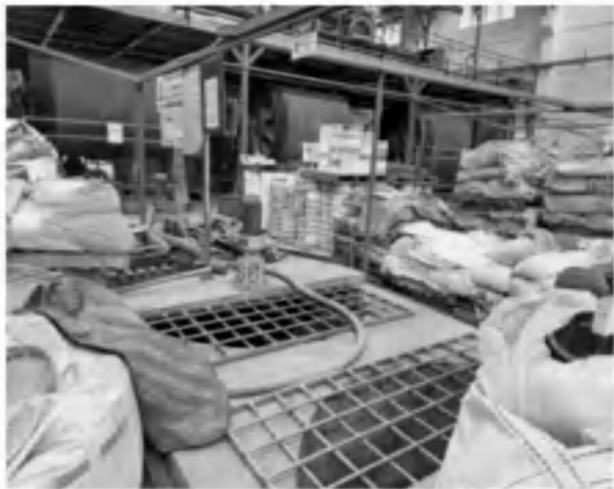
车间一内浆料池（应急时可做事故水暂存设施）
