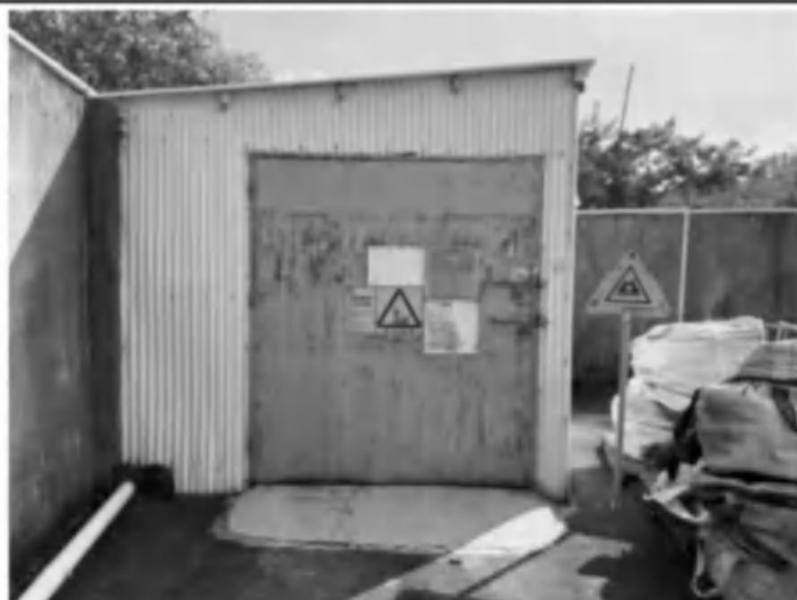
危险废物暂存间
