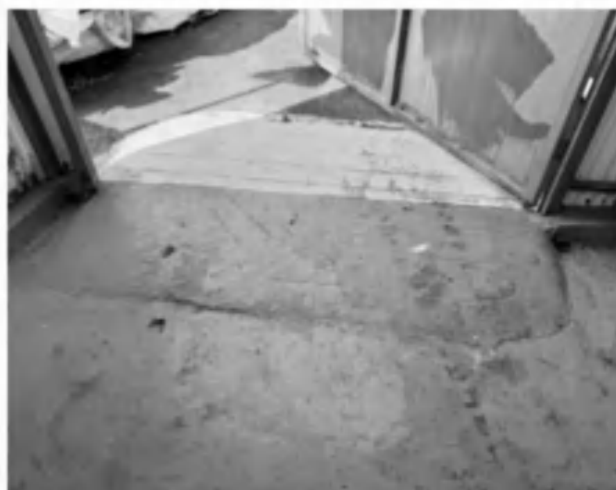
危险废物暂存间慢坡
